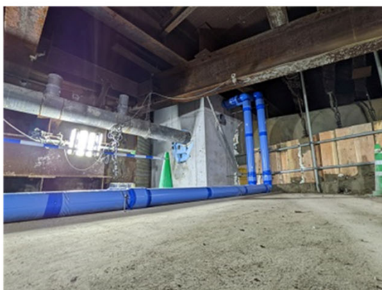
⑥設備工事の進捗状況 (地下駅舎部：下水熱配管設置)
